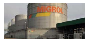
Das Migrol-Tanklager, Uferstrasse
